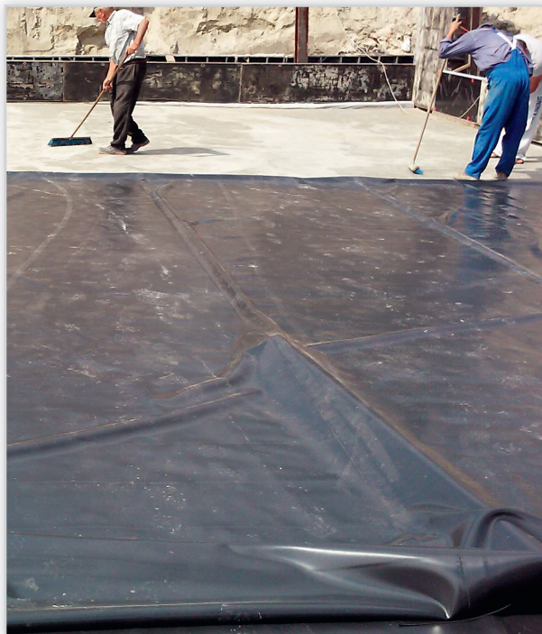
Folia hydroizolacyjna Izowinyl. Szczelna izolacja przeciwna płyty fundamentowej.
