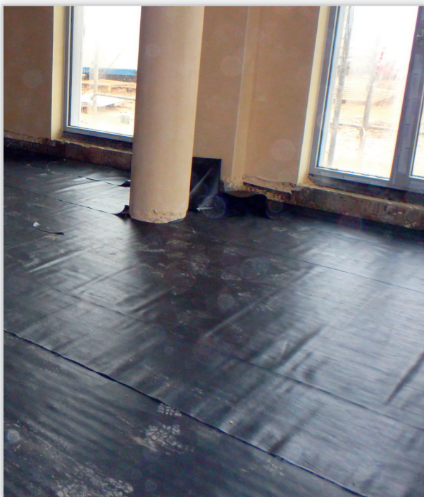
Folia hydroizolacyjna Izowinyl. Izolacja posadzki.
